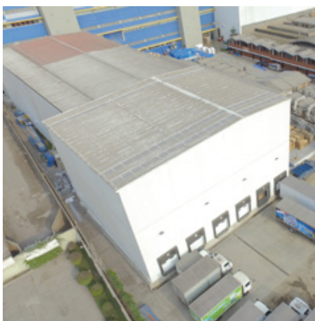
Imagens de um armazém autoportante dedicado a armazenar produtos a temperatura ambiente.
