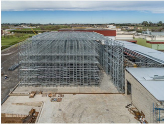
Armazém autoportante com câmara para produto congelado.
