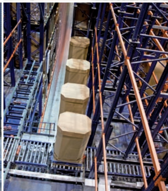
Transportadores de corredor de armazenamento.
