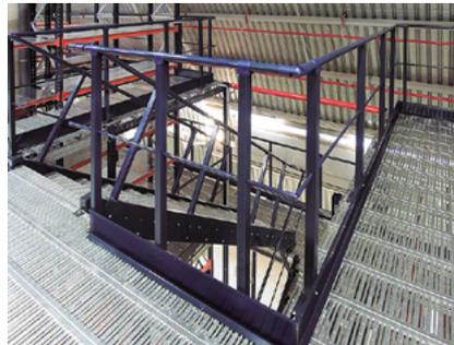
**Varandins.** Os varandins de protecção são feitos com tubos redondos e rectangulares unidos entre si. Na parte inferior colocam-se rodapés para evitar a queda de objetos da plataforma.
