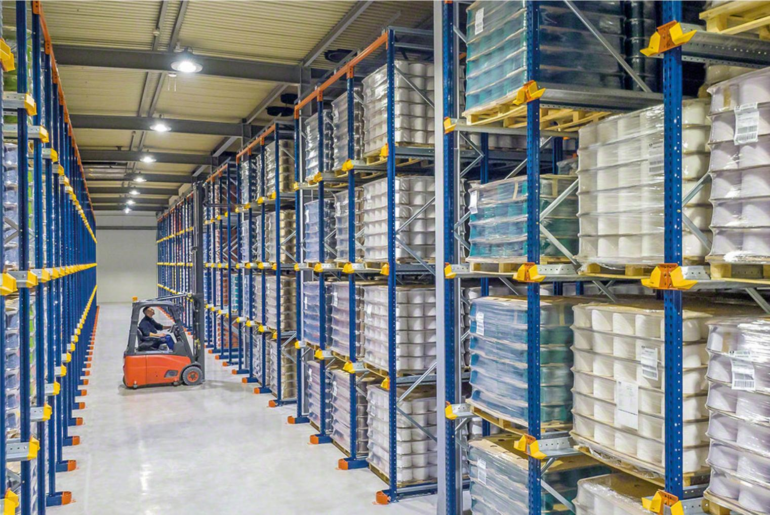
Este sistema de armazenagem está constituído por um conjunto de estantes, que formam ruas interiores de carga, com carris de apoio para as paletes. Os empilhadores entram nestas ruas interiores com a carga elevada por cima do nível no qual vai ser depositada.
