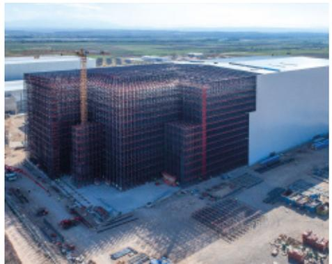
MÁXIMA ALTURA DE CONSTRUÇÃO: PODEM SER CONSTRUÍDOS ARMAZÉNS AUTOPORTANTES A PARTIR DE APENAS 12 METROS E ATÉ 45 METROS DE ALTURA.
